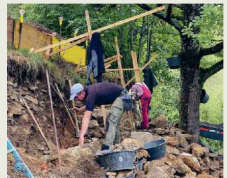
Trockensteinmauersanierung Stockenrain Hellikon.
