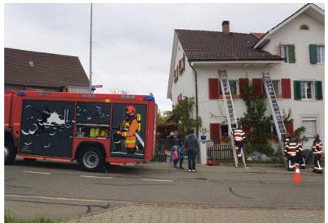
Die Feuerwehr nahm sich der Reinigung der Schwalbennester an.
