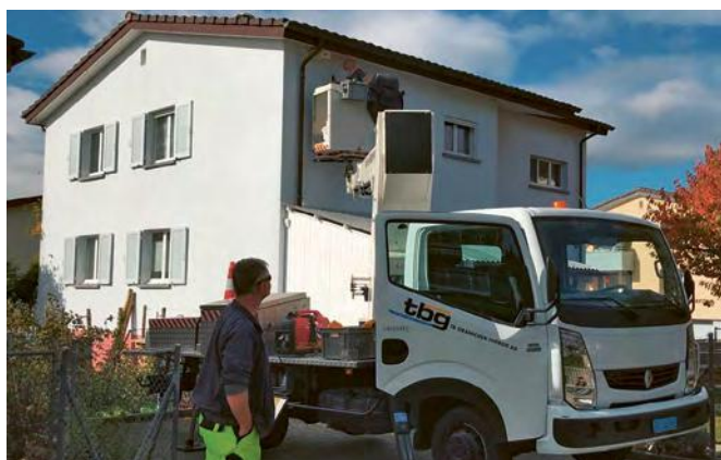
Montage von Nestern mithilfe einer Hebebühne.
