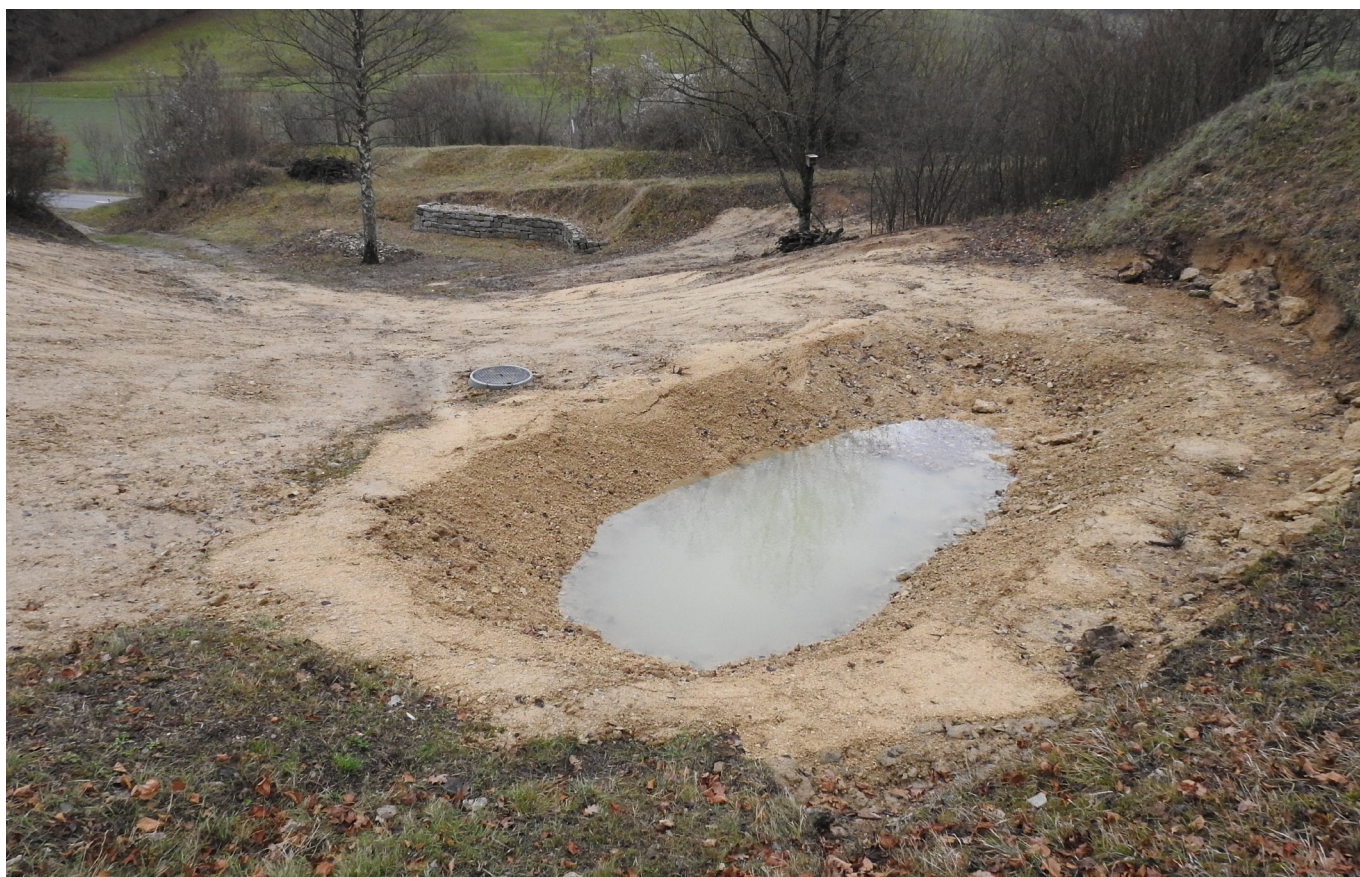
Nachher: Der fertiggestellte neue Teich ist bereits zur Hälfte mit Wasser gefüllt. Die Abbruchkante und die Unterschlüpfе sind am rechten Bildrand zu sehen.
