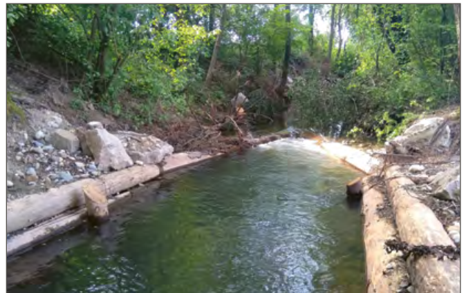
Abb. 6: Die Uerke in Kölliken: Beidseitig unterspülte Ufer sowie v-artig angeordnete Baumstämme sorgen für eine permanent attraktive und tiefe Stelle im Bach.
