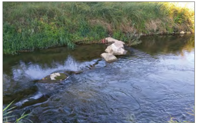
Abbildung 7: Lenkbühnen wie hier an der Suhre sehen unscheinbar aus, bewirken aber in diesem Fall hier eine lokale Bildung eines Kolkes (unten im Bild) und gleichzeitig eine Auflandung (oben im Bild).
