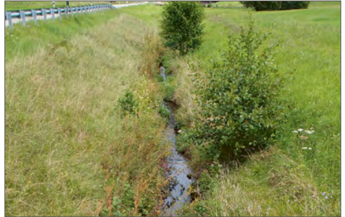
Abb. 5: Der kleine Westerbach in Murgenthal bietet dank der Entfernung der Betonschale und dem Einbringen von kleinen Strukturelementen den Dohlenkrebsen, Forellen, Groppen und Bachneunaugen wieder einen Lebensraum.
