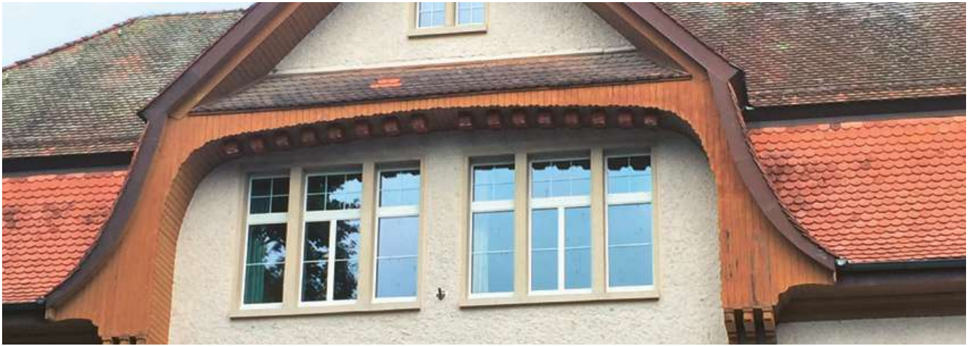
Die 16 Nistkästen am Gemeindehaus, die nach der Renovation der Fassade wieder montiert wurden.
