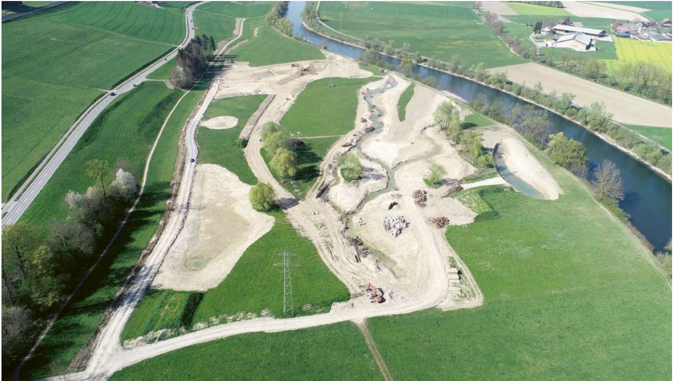
Die Arbeiten der ersten Etappe dauerten von 2019-2020.
