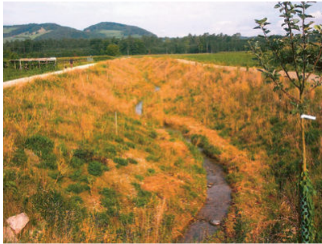
Der Dorfbach ein Jahr nach der Renaturierung: Dem Bach wurde viel Platz eingeräumt, die Breite der Parzelle beträgt 23 Meter.
