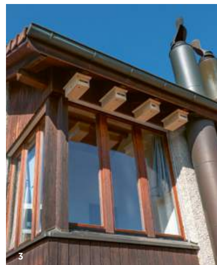
3 Auch Einfamilienhäuser bieten bei freiem Anflug Möglichkeiten für neue Mauerseglerkästen. Zum Anlocken des Koloniebrüters sind mehrere Brutplätze vorteilhaft.
