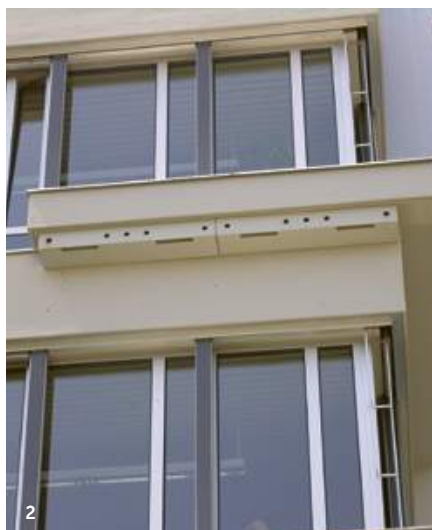
2 Nach der Sanierung der Rollladenkästen an einem Schulhaus in Wettingen wurden als Ersatz Nistkästen für Mauersegler aufgehängt, die erfolgreich besiedelt wurden.
