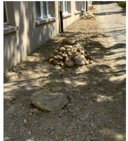
Aufschütten mit Kies, Steinhaufen erstellen.
