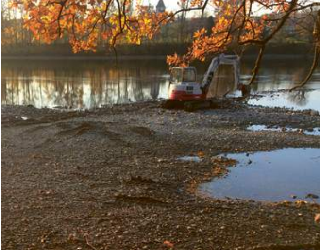
Einbringen von Kies und Auflockerung der Sohle mit einem Bagger bei der Etzgerbachmündung.
