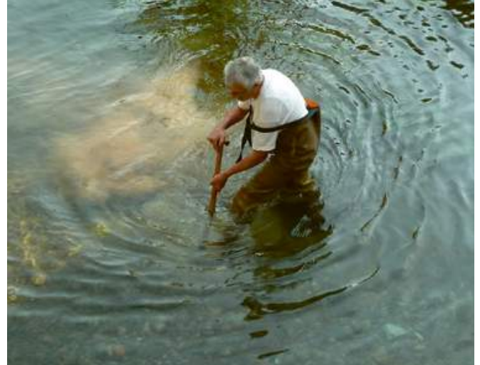
Auflöckerung der Kiessohle von Hand.
