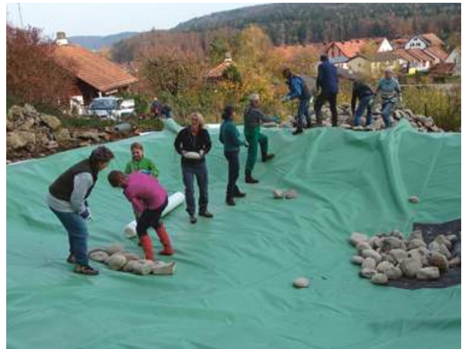
Bau des Teichs Reinwegli, Riniken, im November 2017.
