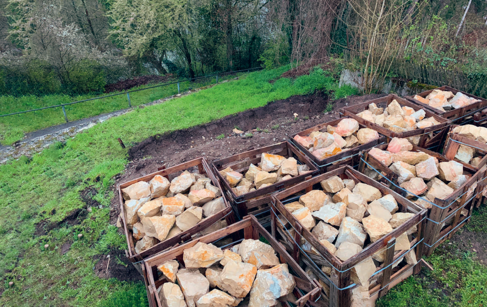
Die Kalksteine für den Mauerbau sind 10–50 kg schwer.
