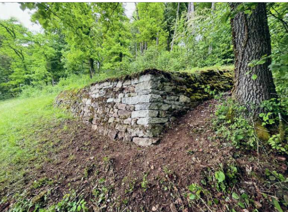
Frisch sanierte Trockensteinmauer im Reservat.
