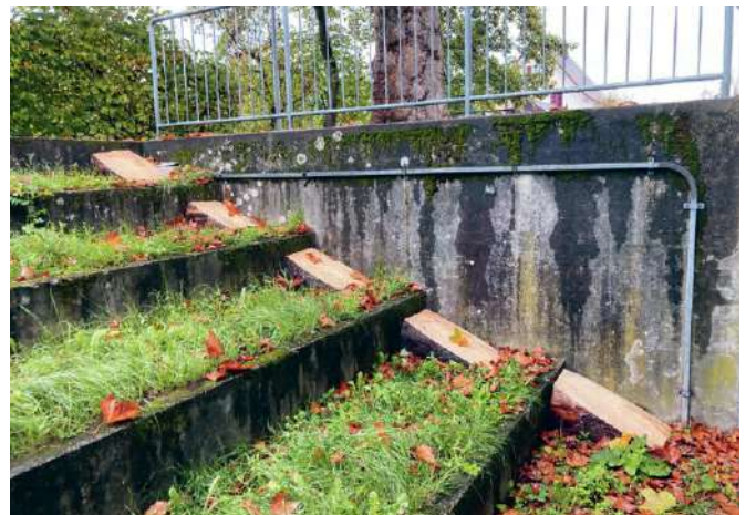
Die neue Rampe für die Igel.
