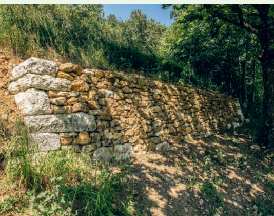
Eine der sanierten Mauern im Bruggletz.
