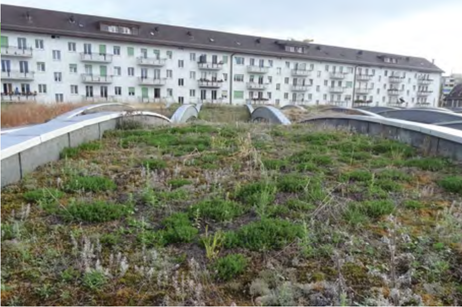
Das begrünte Dach des Tramdepots Wiesenplatz in der Stadt Basel
