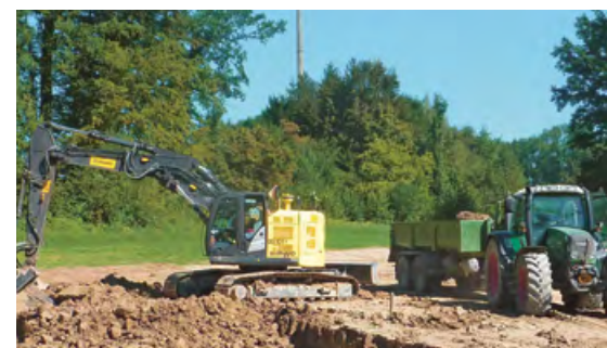
Der Aushub beginnt.
