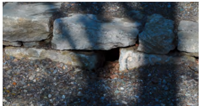
Igelunterschlupf – nur eines der vielen Details für die Tiere, die diese professionell aufgebaute Trockenmauer zu bieten hat.
