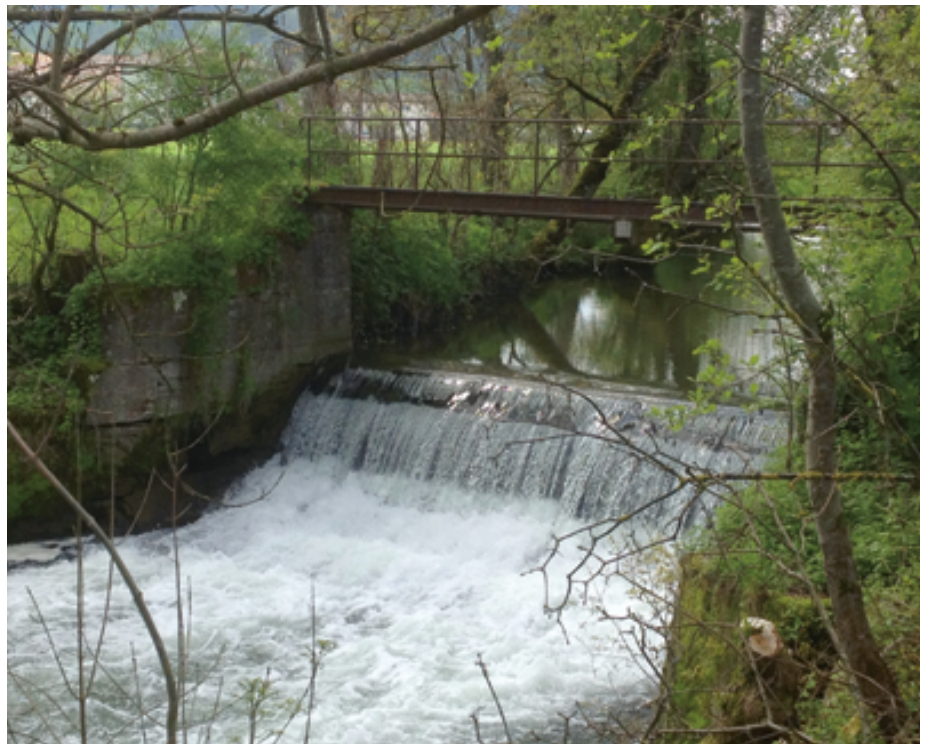
Wehr Bläiematte vor dem Bau des Umgebungsgewässers.
