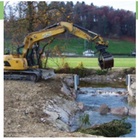
Bau des Einlaufbauwerks.
