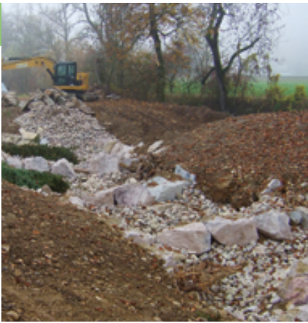
Bau der Riegel im Umgehungsgewässer.
