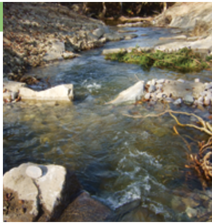
Strukturbildende Massnahmen im Umgehungsgewässer.
