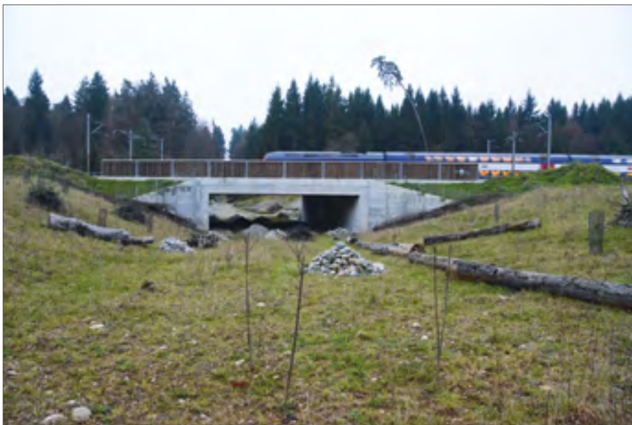
Die Unterführung der SBB 4-Spur Strecke im Suret-Wald wurde im Jahr 2013 auf 15 m verbreitert und mit Leit- und Versteckstrukturen für Wildtiere ausgestattet. Sie ist für den Menschen gesperrt.
