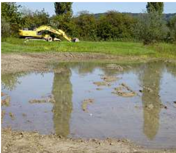
Neue Feuchtstelle im alten Teil.
