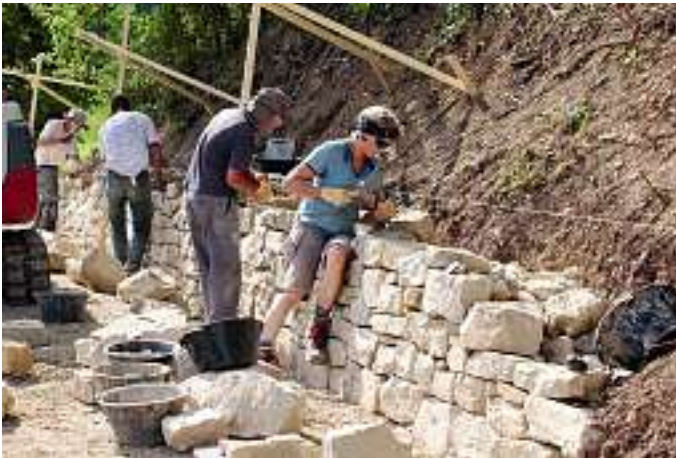
Trockenmauerbau in Wittnau.
