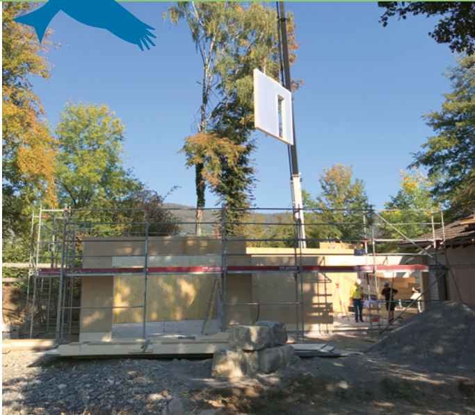
In einem Tag wurde der Anbau aus Holzelementen erstellt.
