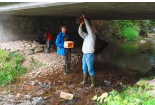
Projekt Wasseramsel: Während den Montagearbeiten. Foto: NV Magden
