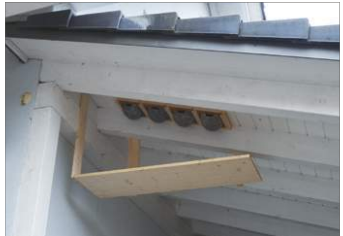
Ein Kotbrett zum Schutz vor Verschmutzung der Hauswand.
