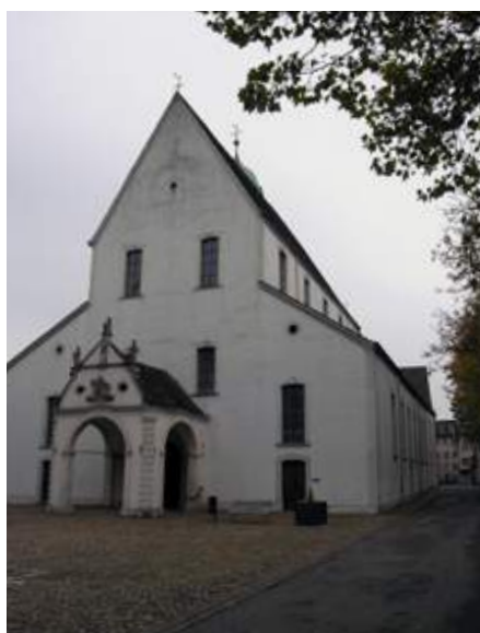
Stadtkirche Rheinfelden. In der Mauer im Hauptschiff sowie am Übergang zwischen Dach und Seitenschiff sind die Ausflugsöffnungen sichtbar. Auf dem Platz vor der Kirche stand die Lunaparkanlage.
