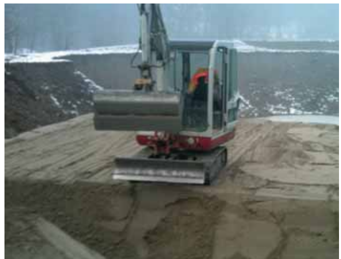
Fisibach: Einbau der Sandlinse in Fisibach (Foto: Markus Spuhler)
