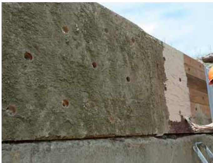
Anbringen von Sand auf die Holzwand für ein möglichst naturnahes Aussehen (Foto: Marco Sacchi)
