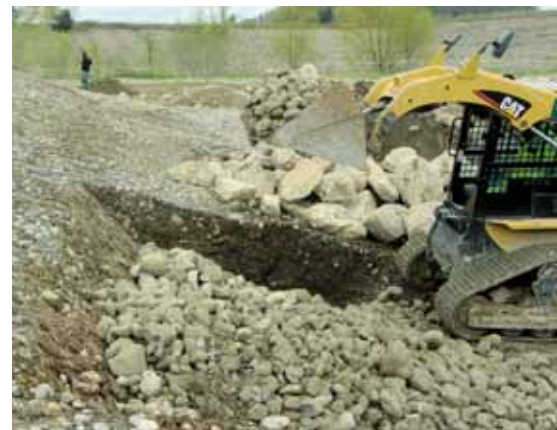
Für den Senksteinhaufen wird eine 2 Meter tiefe Mulde ausgehoben, mit Bollensteinen gefüllt und dann mit plattigen Steinen ebenerdig überdeckt.
