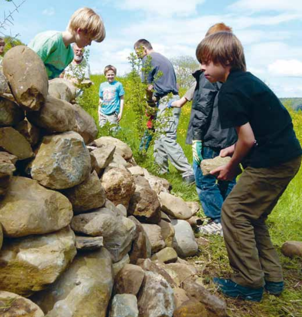
Kleinstrukturen: gemeinsam wird eine Trockensteinmauer gebaut.
