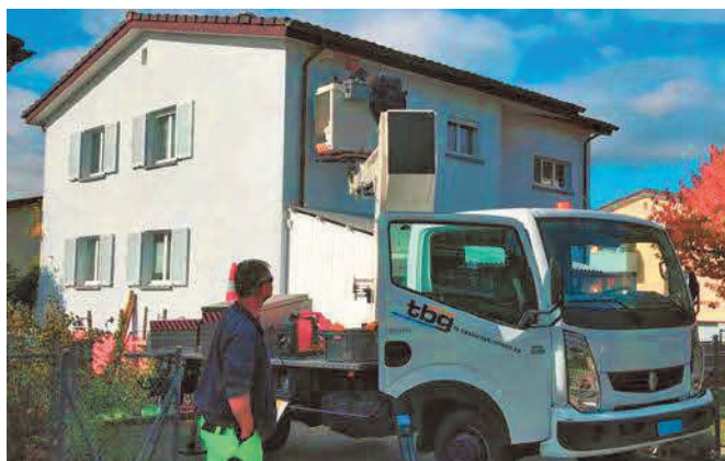
Montage von Nestern mithilfe einer Hebebühne.
