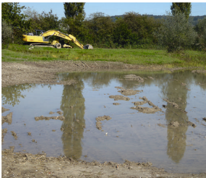
Neue Feuchtstelle im alten Teil.
