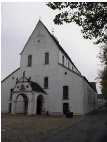
Stadtkirche Rheinfelden. In der Mauer im Hauptschiff sowie am Übergang zwischen Dach und Seitenschiff sind die Ausflugsöffnungen sichtbar. Auf dem Platz vor der Kirche stand die Lunaparkanlage.
